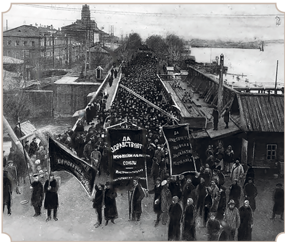
Демонстрация рабочих на плотине перед главным корпусом Ижевского оружейного завода, 1920-е годы
